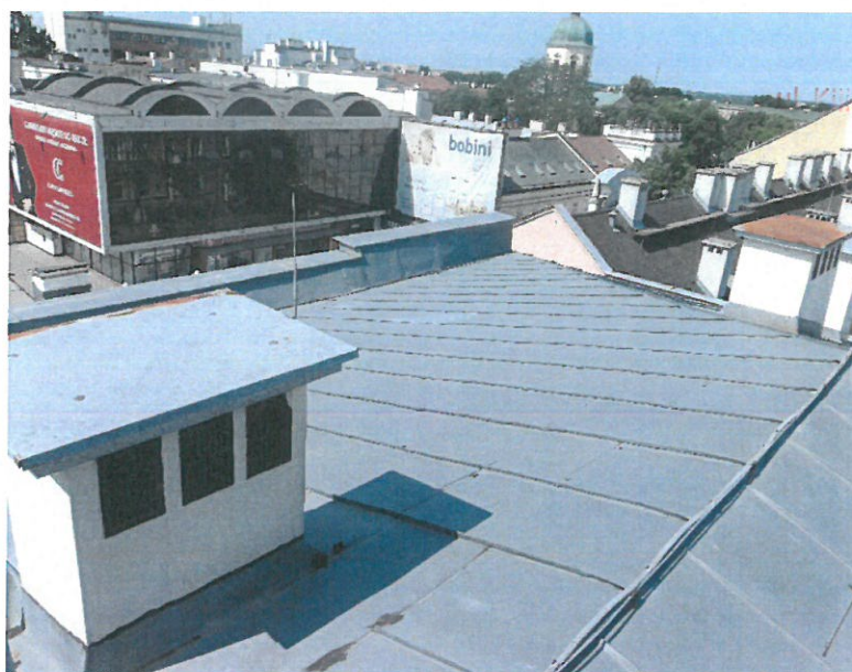
Fot. 14. Naprawy doraźne pokrycia z blachy tytan cynk (lepikiem, taśmami)
