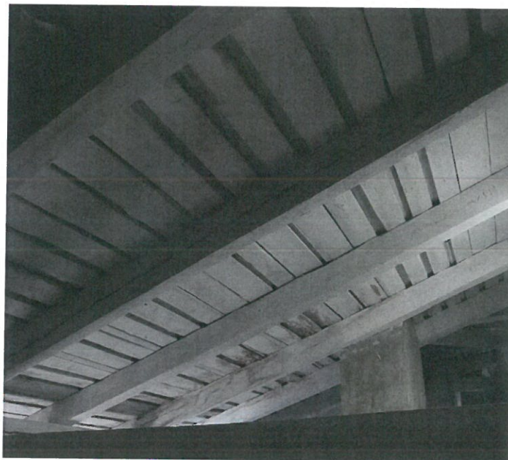
Fot. 10. Deskowanie z prześwitem (z widoczną membraną złej jakości, i z widocznym zbrojeniem do wymiany)
