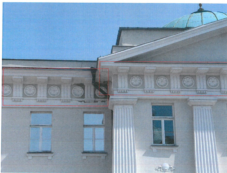
Fot.2. Widoczny zniszczony narożnik gzymsu wieńczącego
