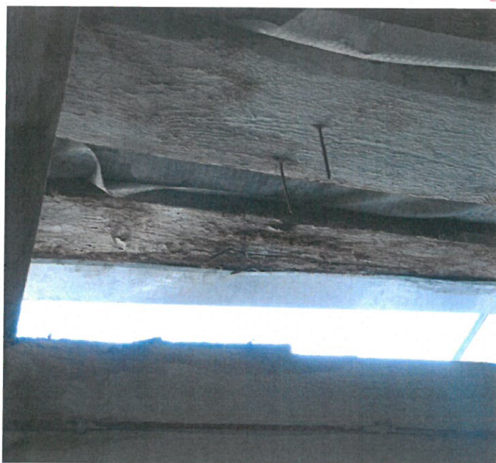
Fot. 11. Deskowanie z prześwitem, widoczne źle montowane haftry (z widoczną membraną złej jakości, i z widocznym zbrojeniem do wymiany)
