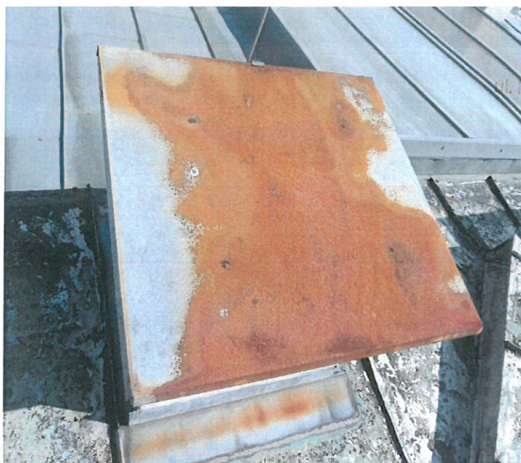
Fot. 16. Czapa kominowa – obróbka blacharska (zardzewiała) (Kwaśne deszcze zdegradowały obróbkę)
