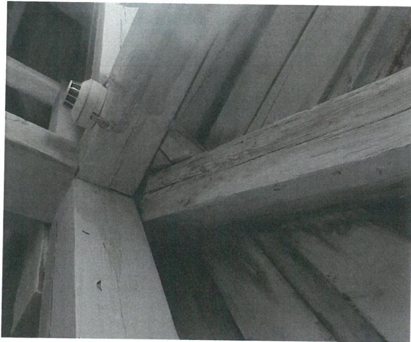
Fot.5. Połączenie krokwi narożnej - zacieki na instalacji p.poż.
