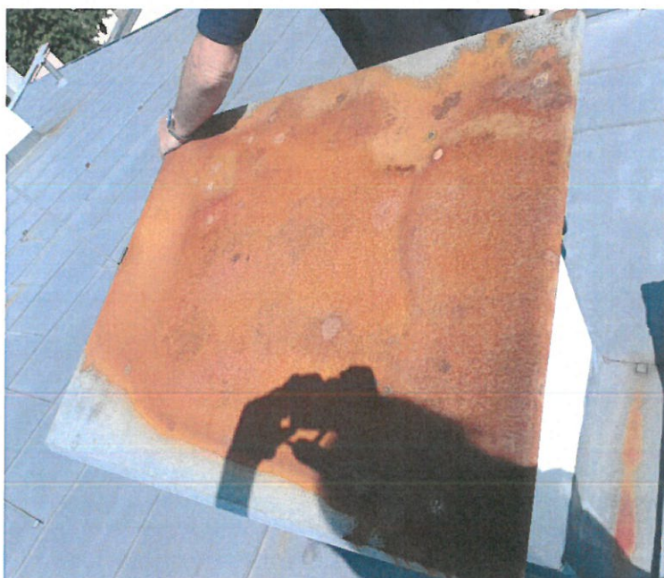
Fot. 17. Czapa kominowa – obróbka blacharska (zardzewiała) (Kwaśne deszcze zdegradowały obróbkę)
