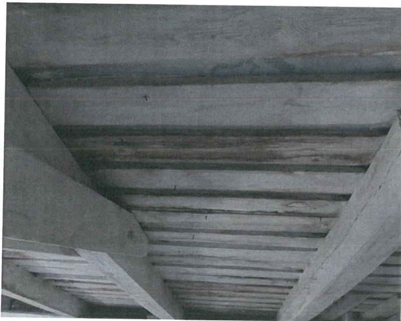
Fot.6. Zacieki na deskowaniu – widoczne źle montowane haftry (przebijające blachę, membranę aż do deskowania, przyczyna przecieków)
