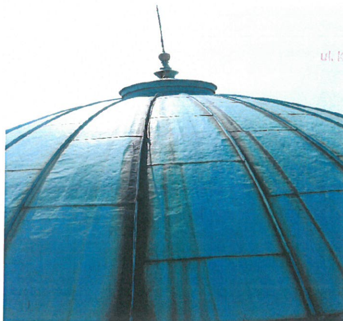
Fot. 18. Kopuła-konstrukcja i pokrycie z blachy miedzianej do zachowania
