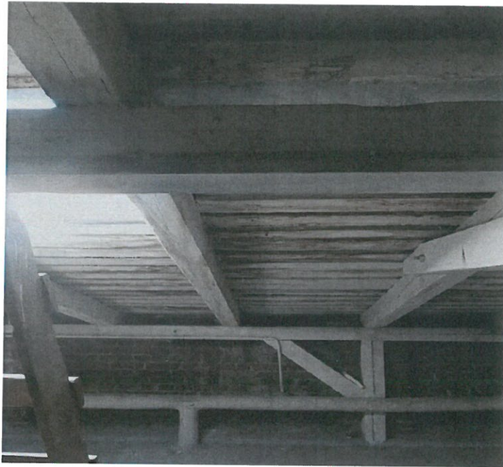
Fot. 9. Zacieki na całej płaszczyźnie deskowania, przy wyłazie na dach
