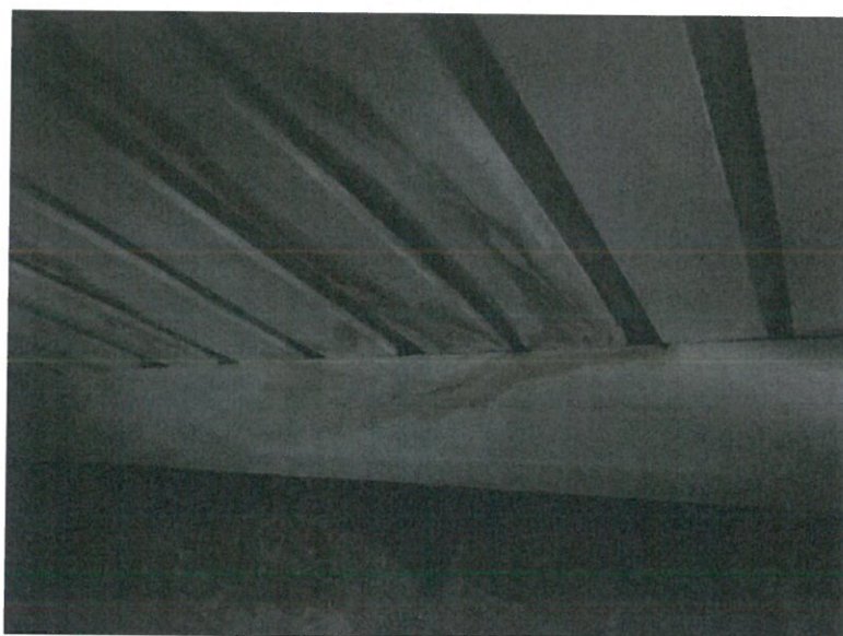
Fot.4. zacieki na deskowaniu i krokwi przy ścianie szczytowej
